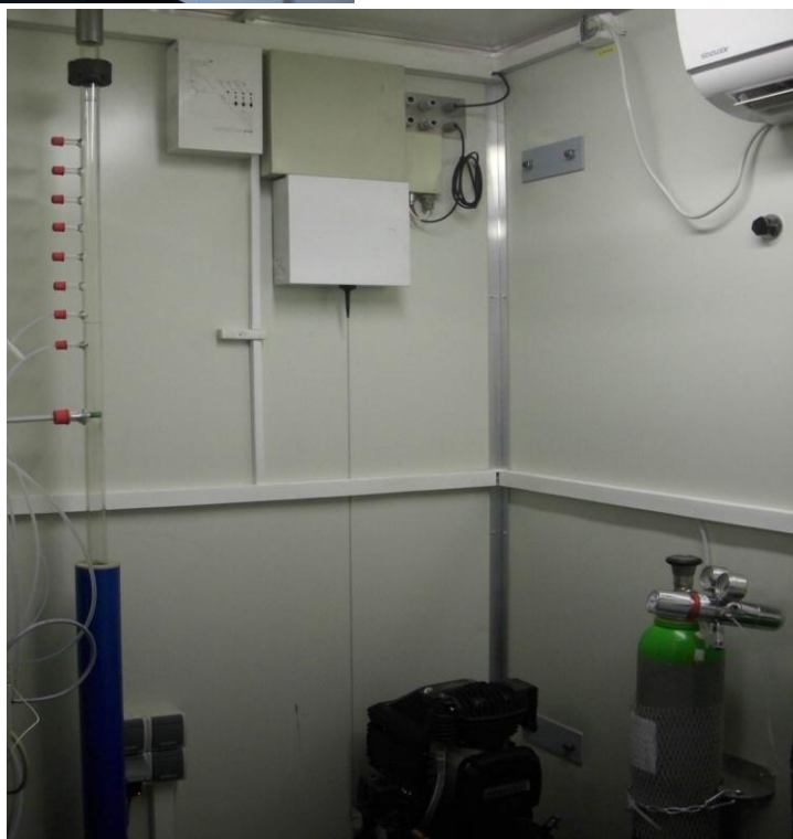
Widok stacji pomiarowej AM1 po modernizacji
