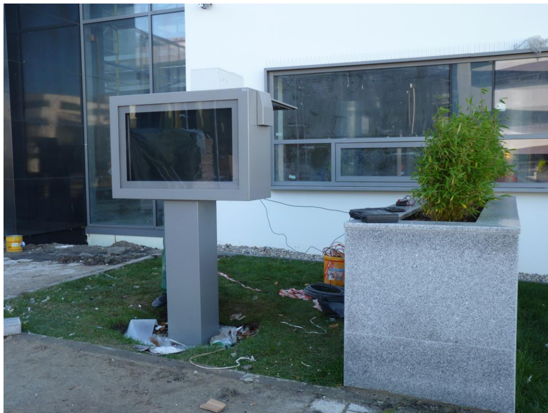
Ryc.16. Panel zewnętrzny na Campusie UG w Oliwie.
